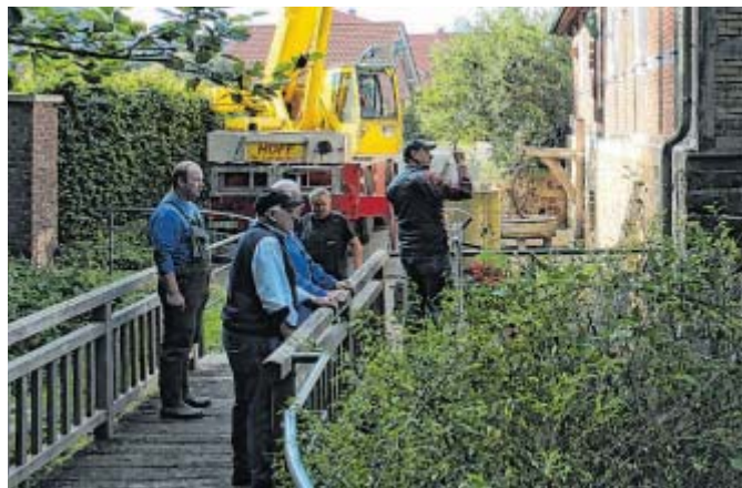
Es wird gearbeitet: Das Wasserrad am Heimathaus Feldmühle wurde restauriert und wird sich nun bald wieder in der gewohnten Weise drehen.
